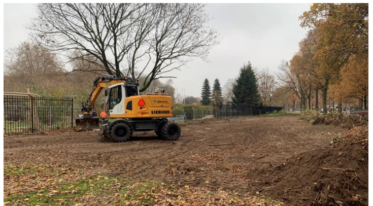
Vorbereiding voor de aanleg van de beek bij de Elckerlyc (foto: Henk Smouter)
