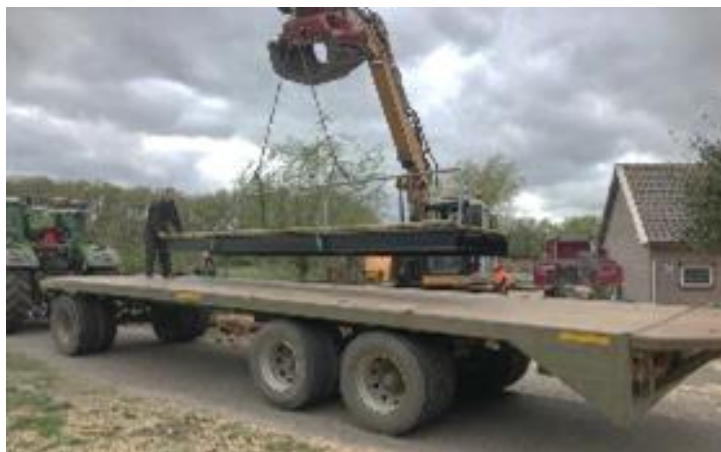
Het opladen van de brug in de Tolstraat
